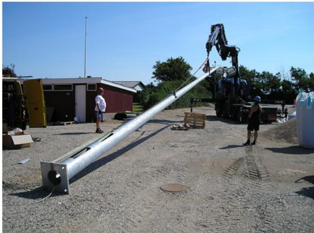
1. Mast nu samlet og løftes i øverste mastedel i topstrop op i ca. 45°
