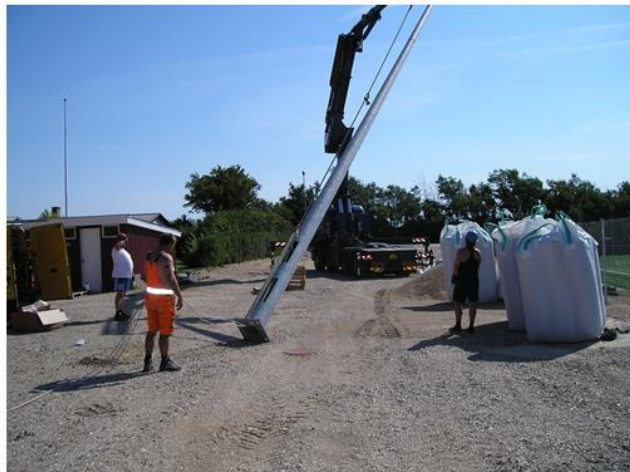
2. Mast løftes af bundstrop + topstrop mod lodret position.
