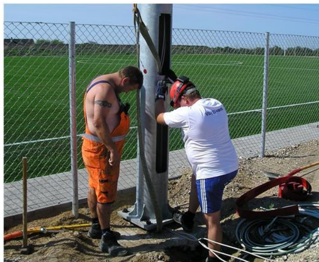
6. Masten på plads - undgå at beskadige boltene s gevind.
