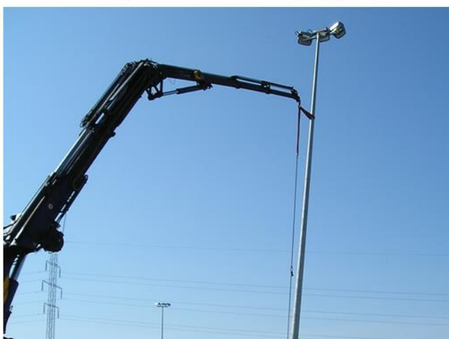
3. Mast løftes af bundstrop op i lodret position over niveau.
